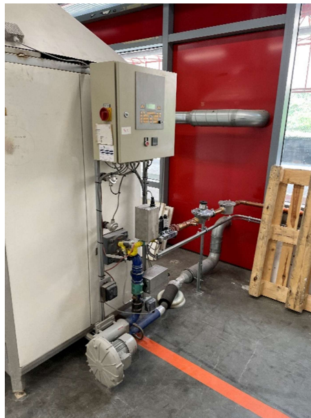
Gasaansluiting keramiek oven
