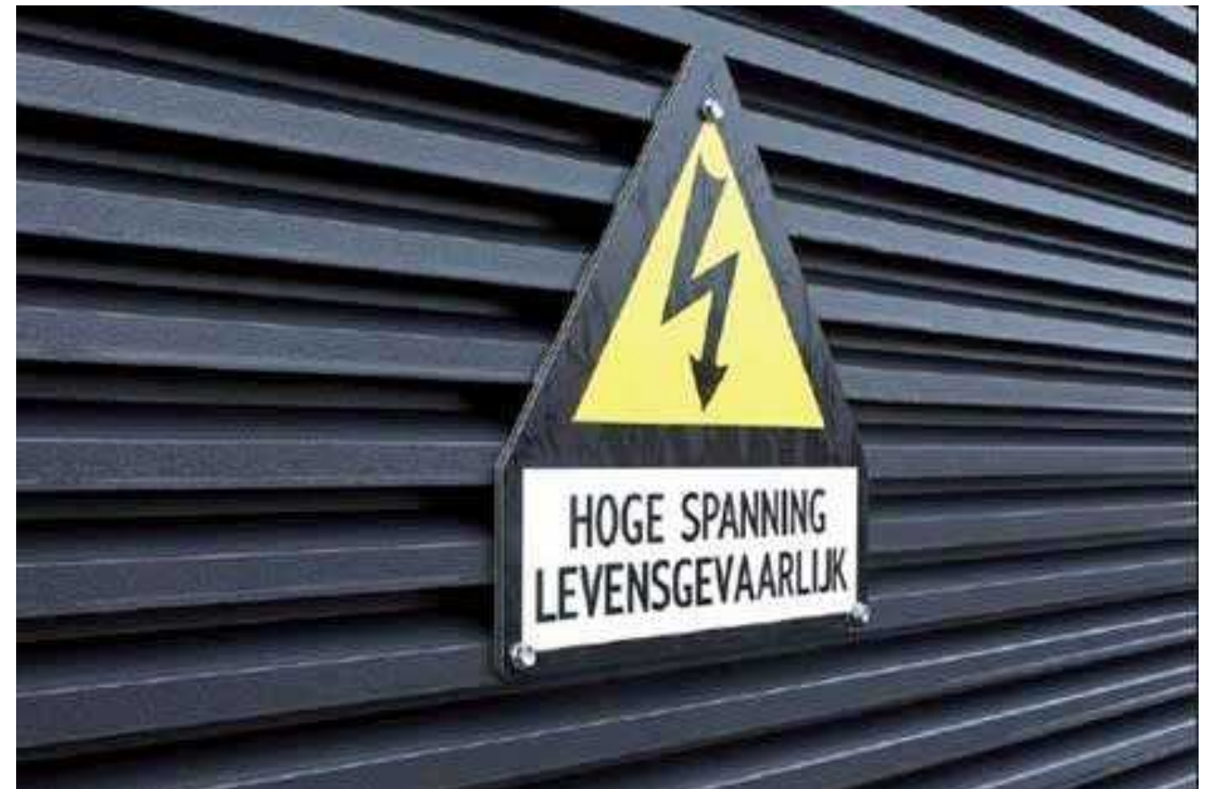
De lamellen zorgen voor ventilatie
