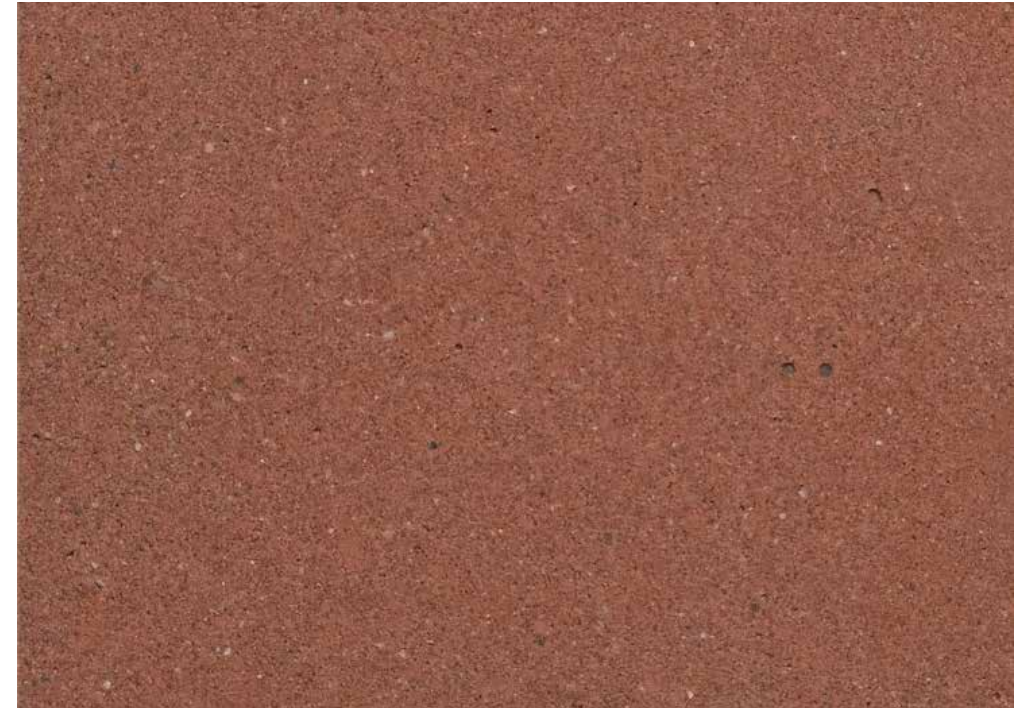
Gekleurd beton in vergelijkbare kleur en textuur als het metselwerk
