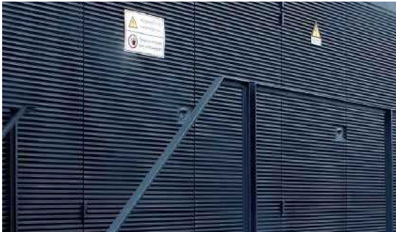
Deuren zijn onopvallend weggewerkt in de gevel
