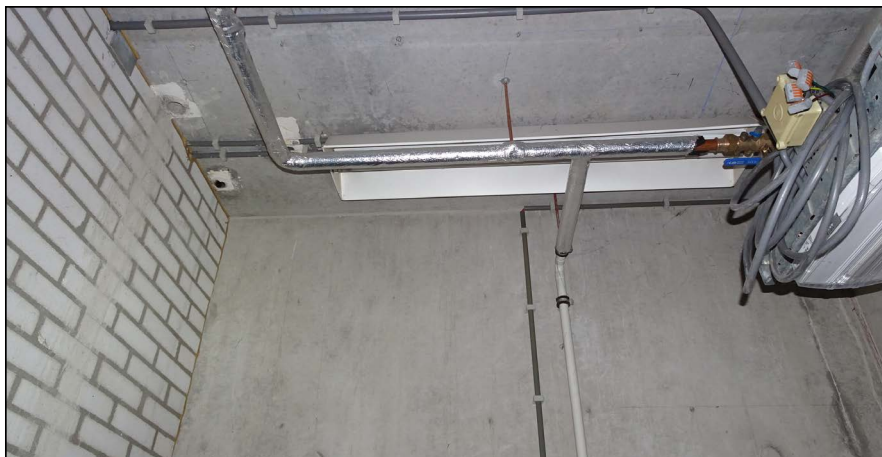
Figuur: kelder onder ronde gebouw is overal goed afgedicht naar buitenmuren.
