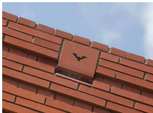
Vleermuis kast in de spouw. Aangezien de gevel van de parkeergarage niet geïsoleerd hoeft te worden is er voldoende ruimte in de spouw.
