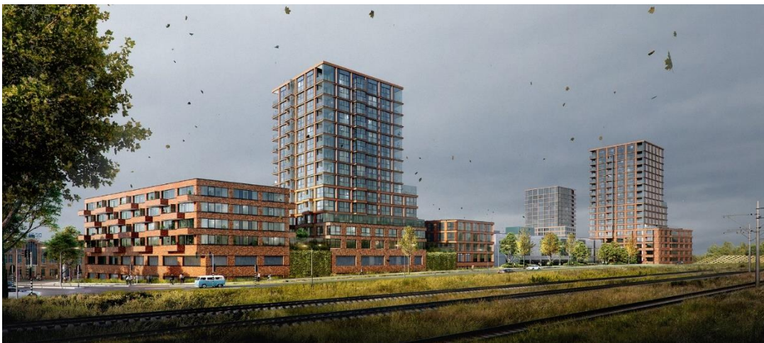
Afbeelding 4.2 Impressie bebouwing Fase 1 vanaf de Nelson Mandelalaan: gebouwen M, K en I (op gezamenlijke plint), KuBus en F (copyright AbsentMatter)
