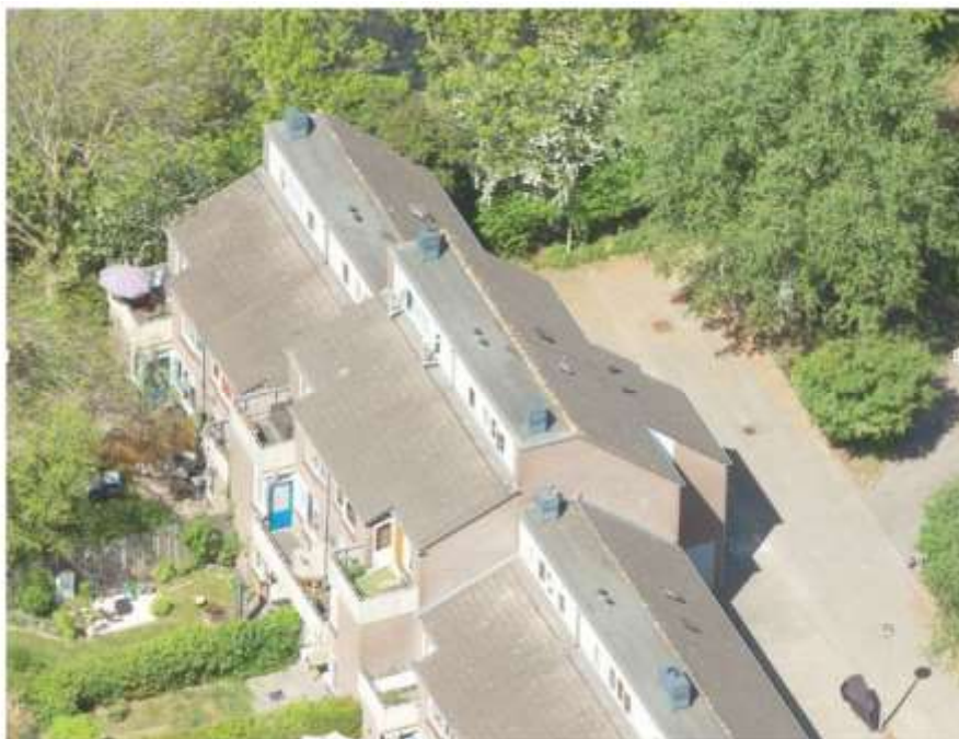
Figuur 1. Deel van appartementencomplex Klarissenstraat dat een verdieping uitsteekt.
