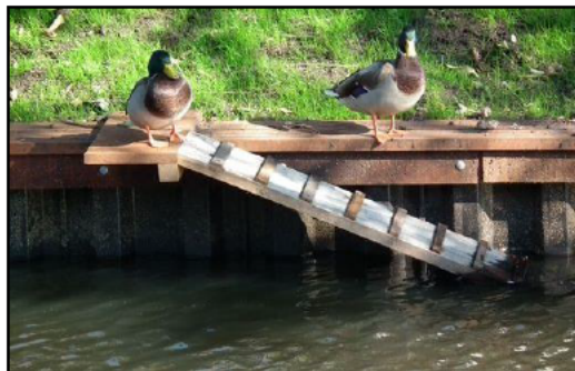
Afbeelding 6: Fauna-uitstapplaats (FUP) die langs de damwanden langs de oevers binnen het plangebied geplaatst kan worden (bron: Seine Schelde Vlaanderen).
