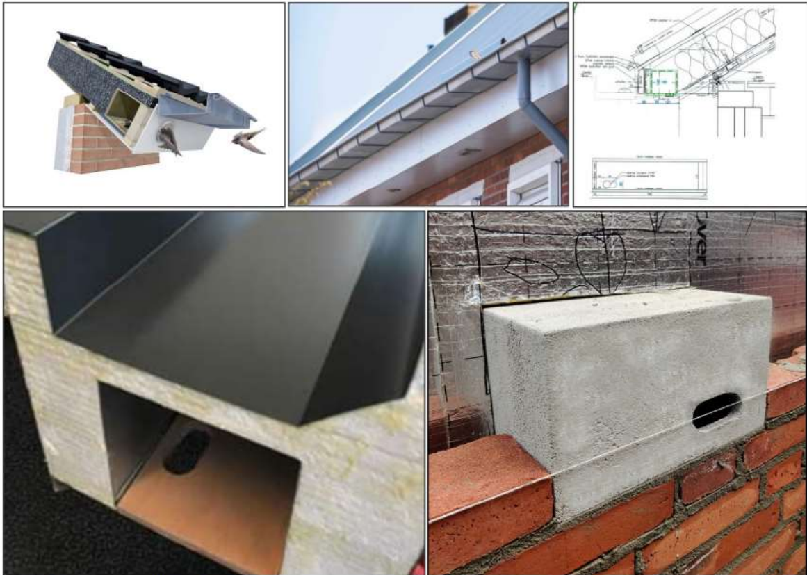
Figuur 3.8 Voorbeelden van permanente nestvoorzieningen; nestkast in dakrand, achter of onder dakgoot, in metselkasten.
