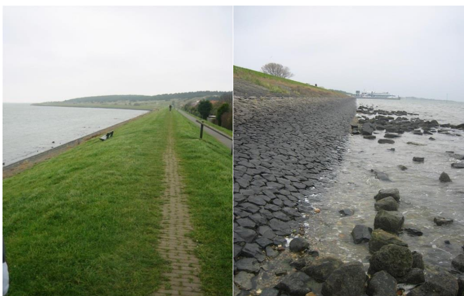
Afbeelding 3-1 Rechts: situatie vanaf de kruin en links de situatie gezien vanaf de teen van de dijk. Foto's: RHDHV
