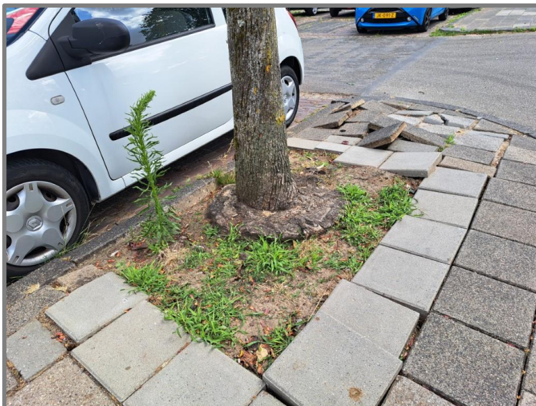
Fig. 1: Het bijna 50 jaar oude boompje staat al zijn gehele leven te kwarren vanwege de inferieure ondergrondse groeiplaats en is nu afstervend (links). De boom heeft een extreem brede stamvoet gevormd (rechts) rondom de boomspiegel liggen veel trottoirtegels los, waarschijnlijk door het kiepen van de boom tijdens een recente storm.
