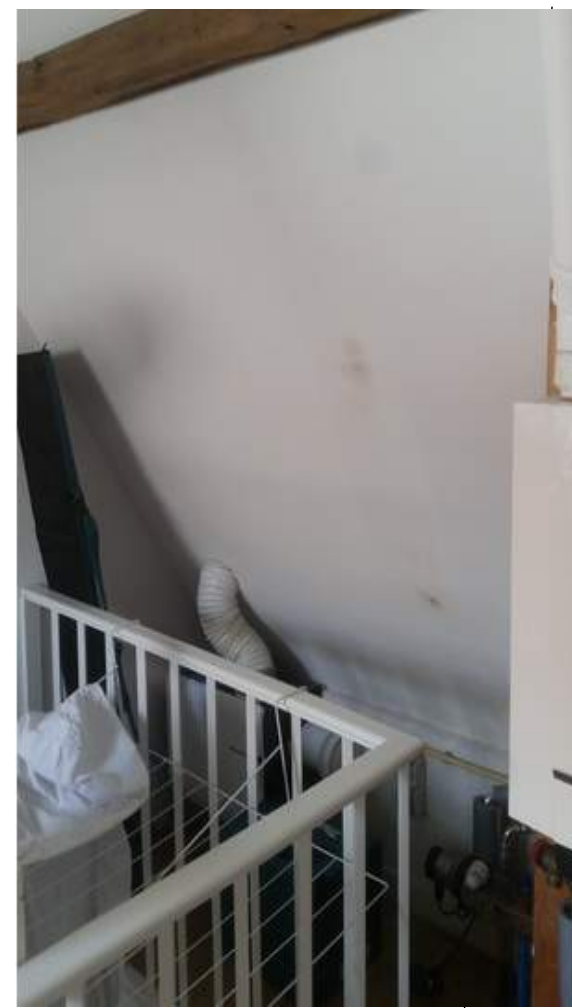
FOTO bestaand achterdak ruimte r2.1
