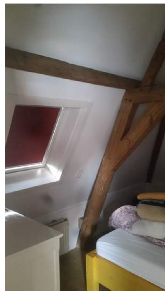
FOTO bestaand dakraam
