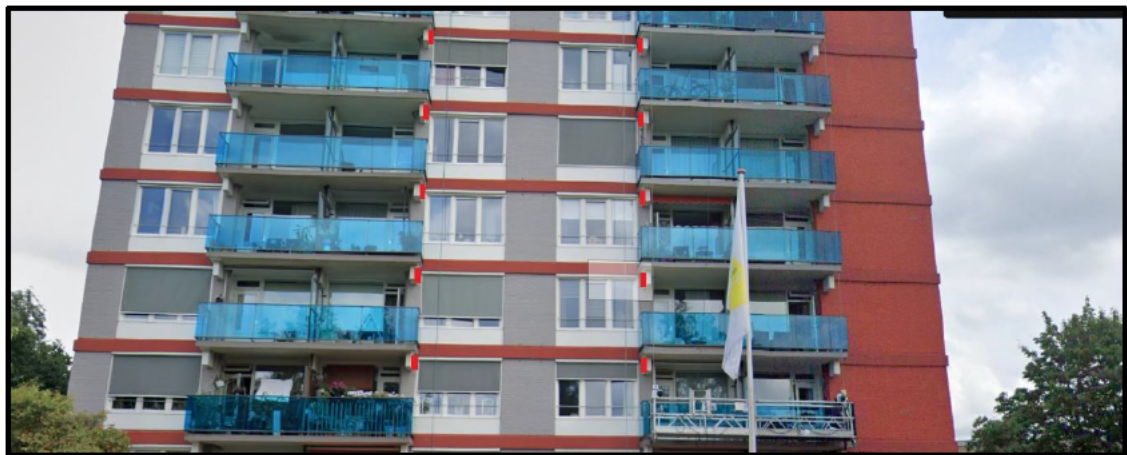
Figuur 3: De locaties van de 10 tijdelijke vleermuiskasten, aan de steunpalen van de balkons aan de westelijke gevel (rode rechthoeken).
