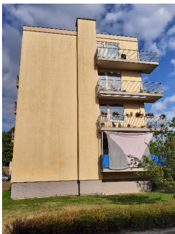
Figuur 5.10: Aanzicht balkon kopgevel.
