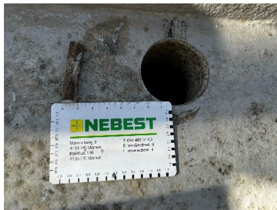
Figuur 4.8: Verifiëren wapening balkon voorgevel.
