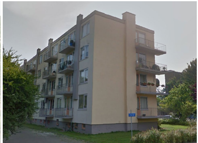
Figuur 2.3: Uitkragende balkonvloeren gesitueerd aan de kopgevel en achtergevel.
