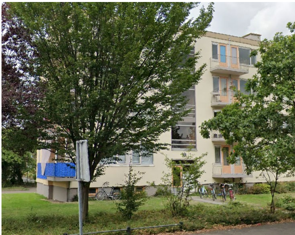
Figuur 2.2: Uitkragende balkonvloeren gesitueerd aan de voorgevel.
