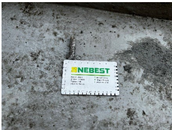
Figuur 4.7: Verifiëren wapening balkon kopgevel.
