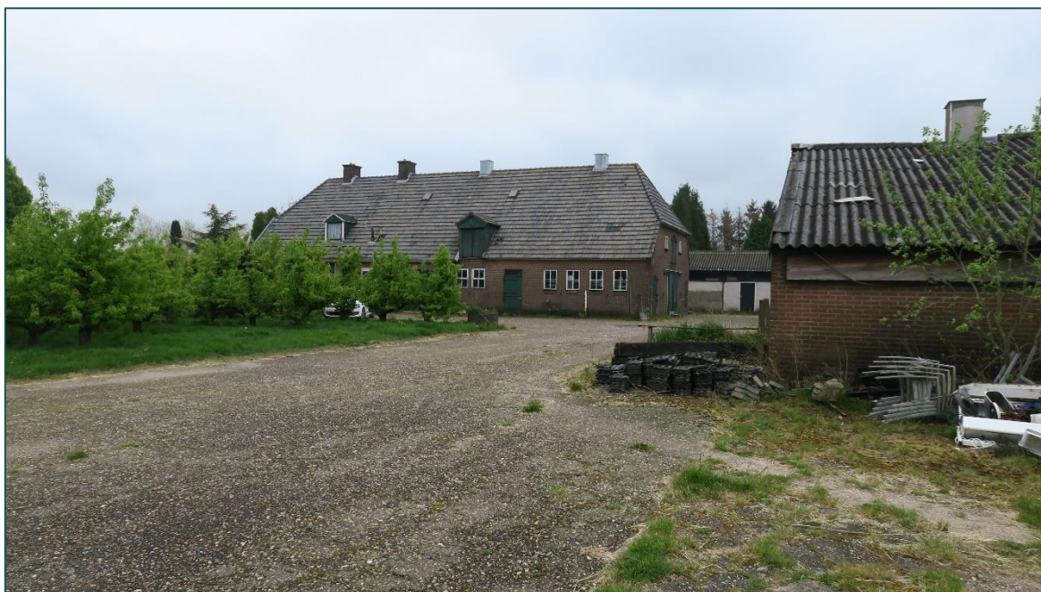
Figuur 1 De planlocatie is gelegen aan de Flierensestraat 3-3a te Gendt en bestaat uit een woning, 2 loodsen en opstallen. De beoogde ruimtelijke ingreep betreft de sloop van 2 loodsen ten behoeve van de bouw van een woning.
