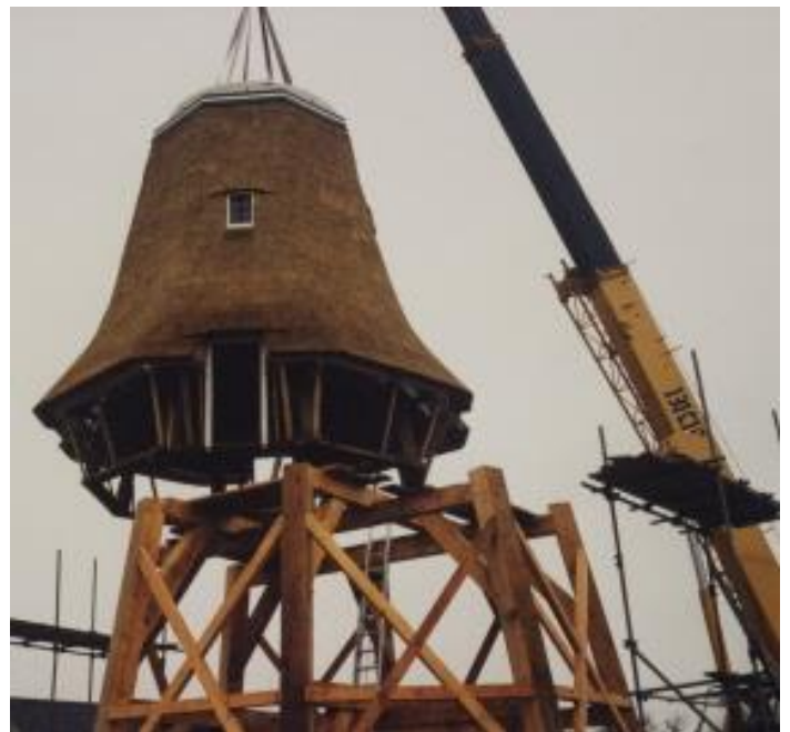
Plaatsing achtkant 16-1-1992. Bron www.allemolens.nl
