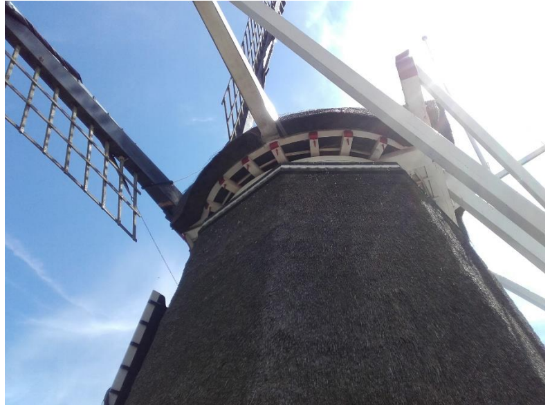
Onderaanzicht constructie molenkop
