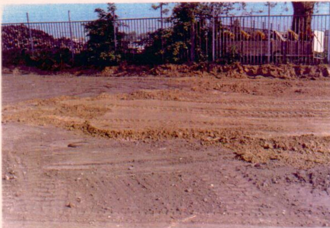
Tijdelijke afdekking met zand in afwachting van de bouw
