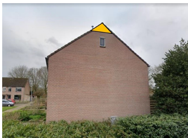
Figuur 10: Indruk van het gedeelte van de spouw dat in het kader van permanente mitigatie voor de laatvlieger wordt vrijgehouden van spouwisolatie. De linkerfoto betreft een kopgevelwoning aan de Esselenbroek, rechts de Peppelenhof. Het vrij te houden gedeelte van de spouw (75 centimeter) is hier weergegeven in oranje. De invliegopening komt bij de nokvorst. Afbeelding: Econsultancy 2023.
