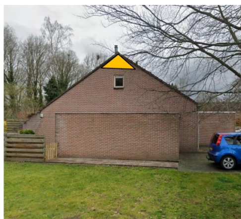
Figuur 10: Indruk van het gedeelte van de spouw dat in het kader van permanente mitigatie voor de laatvlieger wordt vrijgehouden van spouwisolatie. De linkerfoto betreft een kopgevelwoning aan de Esselenbroek, rechts de Peppelenhof. Het vrij te houden gedeelte van de spouw (75 centimeter) is hier weergegeven in oranje. De invliegopening komt bij de nokvorst. Afbeelding: Econsultancy 2023.
