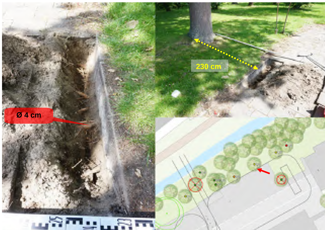
Profielsleuf 7: Overzichtsfoto en locatie (rechtsboven) en detailfoto van de profielsleuf (Links). De rode pijl rechtsonder geeft de locatie van de proefsleuf weer, de dunne belijning situeren het ontwerp.
