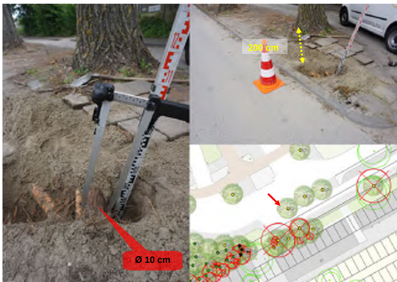
Profielsleuf 3: Overzichtsfoto en locatie (rechtsboven) en detailfoto van de profielsleuf (Links). De rode pijl rechtsonder geeft de locatie van de proefsleuf weer, de dunne belijning situeren het ontwerp.
