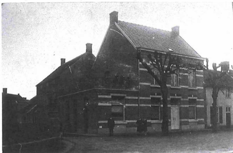
Oude foto waarop dakpannen te zien zijn
