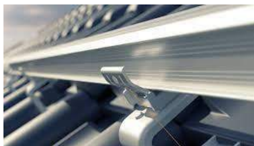
Schuin dak constructie
