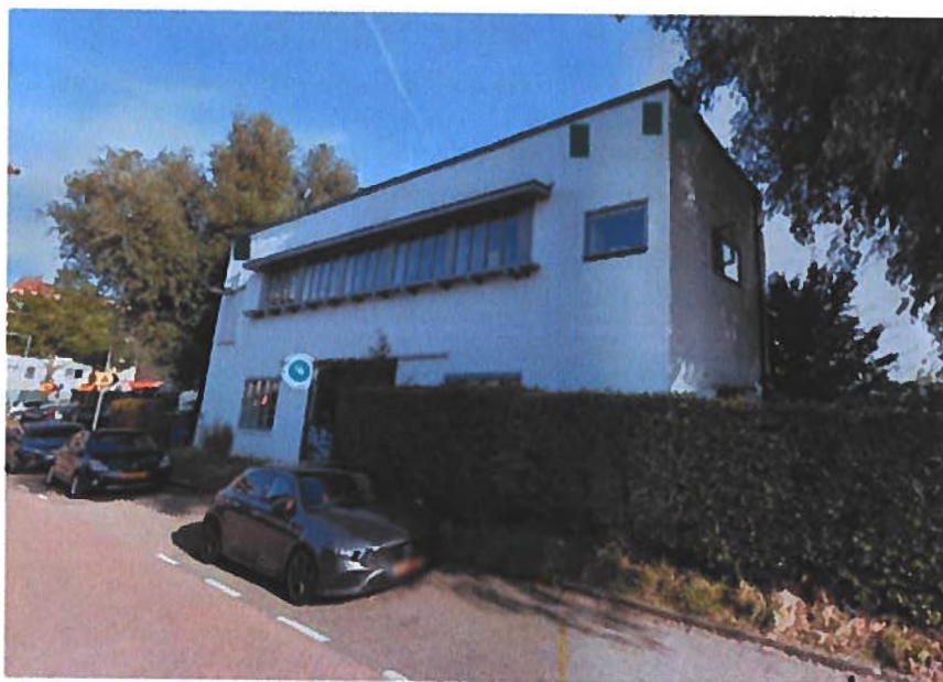
Figuur 5: Tijdelijke kasten voorzijde Asterdwarsweg 10
