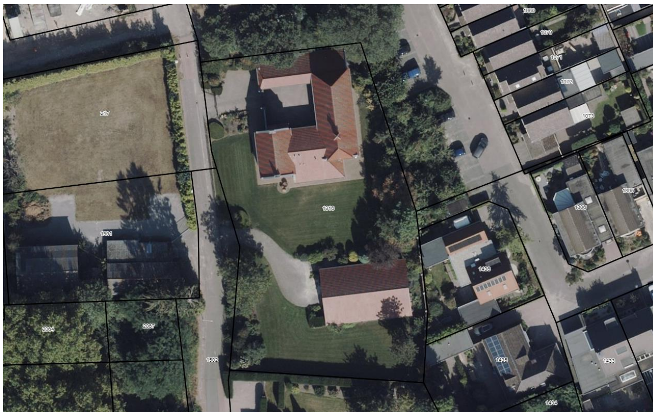
Figuur 2.1.1: Luchtfoto locatie Flemingstraat 6 (bron: streetsmart.cyclomedia.com).
