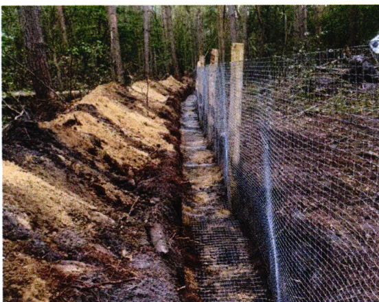
Figuur 1: voorbeeld van aanleg dassenraster door DWT zelf uitgevoerd in 2020
