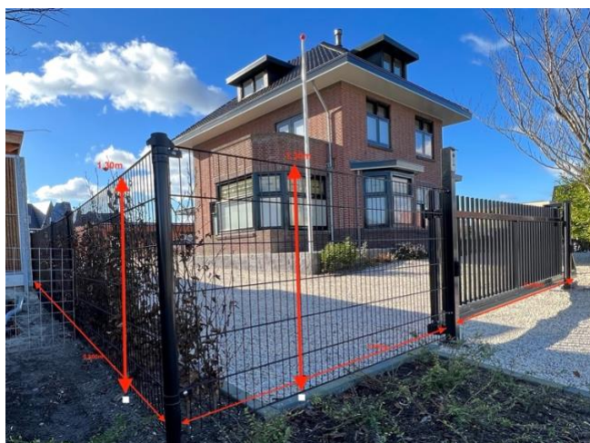
Foto 4: Het voorste deel met een korte deel (2,600m) en een schuifport (5,000m). Hoogte 1,30m. Over deze hoogte van dit deel loopt een aparte aanvraag bij de gemeente (de heer Schadde van Dooren)
