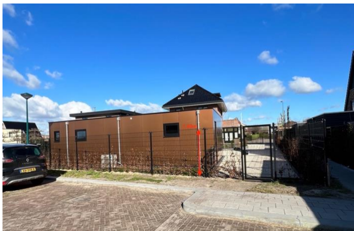
Foto 2: Het achterdeel deel op de achter erfgrens (16,550m). Hoogte 1,80m
