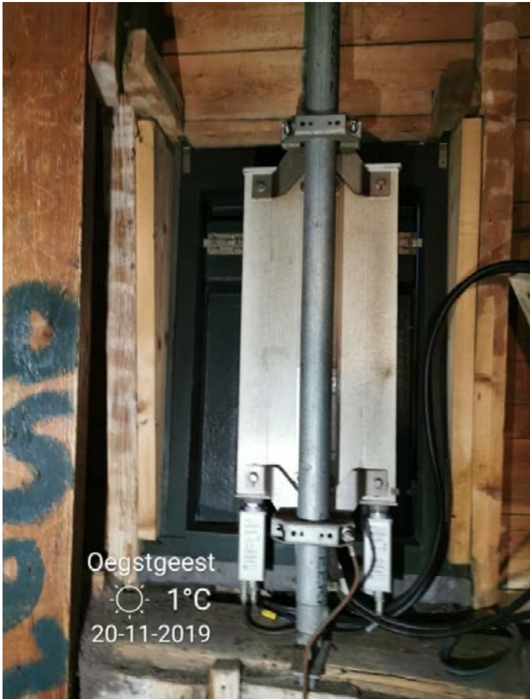
Afbeelding 3 Bestaande antenne hoog in spits.
