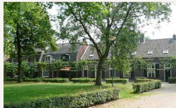
Straatbeeld van de Burgemeester Verwielstraat (noord)
