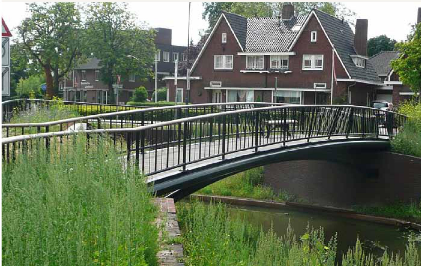
Referentie bruggen Voorste Stroom
