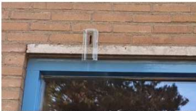
Detail exclusion flap voor het afdichten van open stootvoegen. Deze kan ook gebruikt worden, in combinatie met kitrugvulling, voor het afdichten van kieren.
