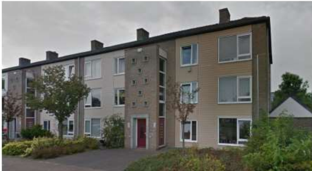
Figuur 6: Voorbeeld van hoe de voorgevel van de projectpanden er uit zien. Alle projectpanden zijn gelijk in vorm en verschillen alleen in lengte/aantal stukken gevelbekleding per pand.
