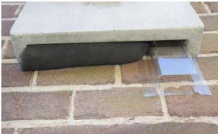
Detail muurschaal met exclusion flap en afgesloten met rugvulling.
