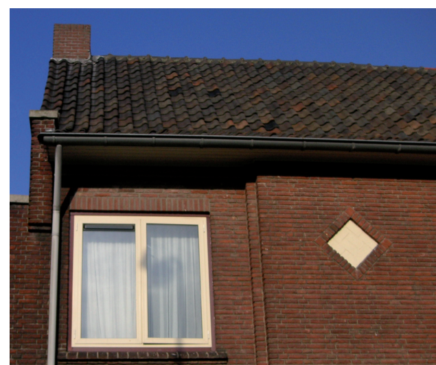
Deelgebied D - zorgvuldig metselwerk
