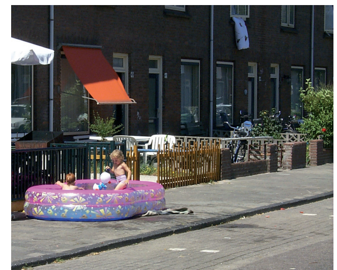
Gerard Doustraat - verwaarloosde tuinmuren
