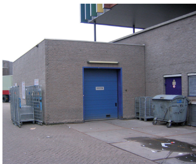
Binnenzijde Haagdijk - blinde achtergevels
