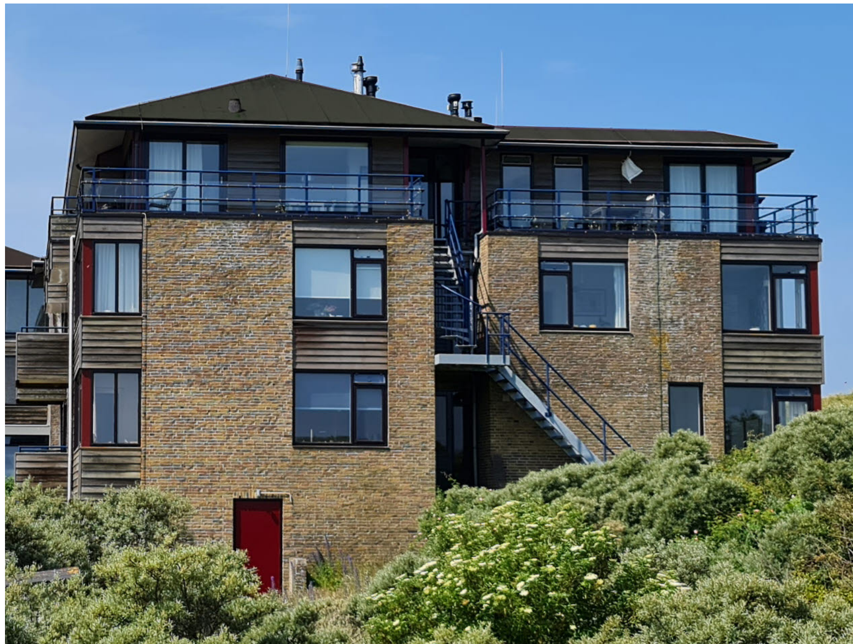
impressie fragment noord-oostgevel
