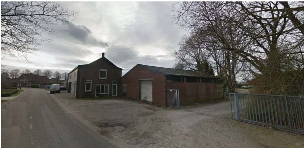
Afbeelding: rechter zij aanzicht kantoor en op termijn te slopen bedrijfsgebouw, waarvoor een woning in de plaats komt
