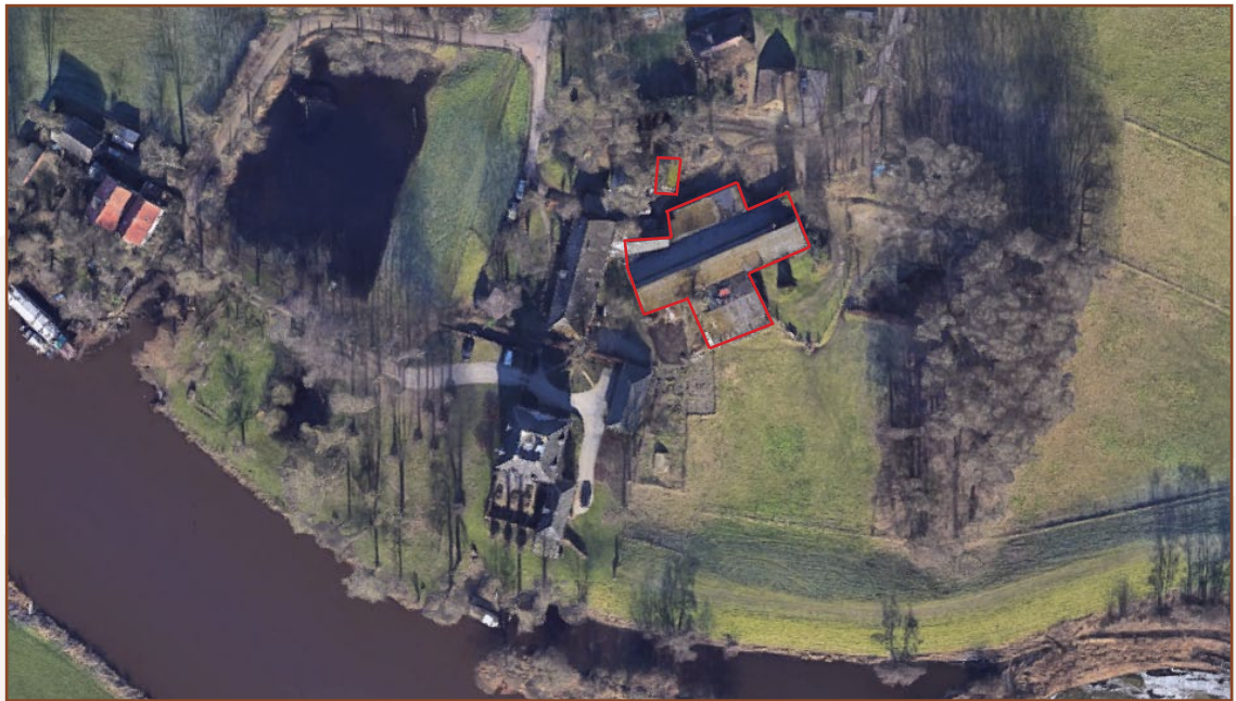
Afbeelding 1: Luchtfoto onderzoeksgebied De Doornweg 15a te Zwolle met de te slopen bebouwing (rood kader). Bron: GoogleMaps
