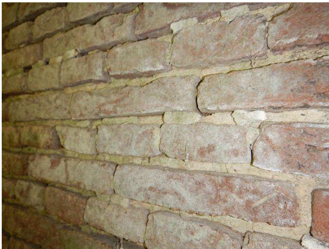
07 Muur is opgetrokken in kruisverband en met kalkmortel gelegd en gevoegd.
