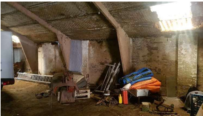
Huidige tuinmuur met hiertegen de later gebouwde schuur
