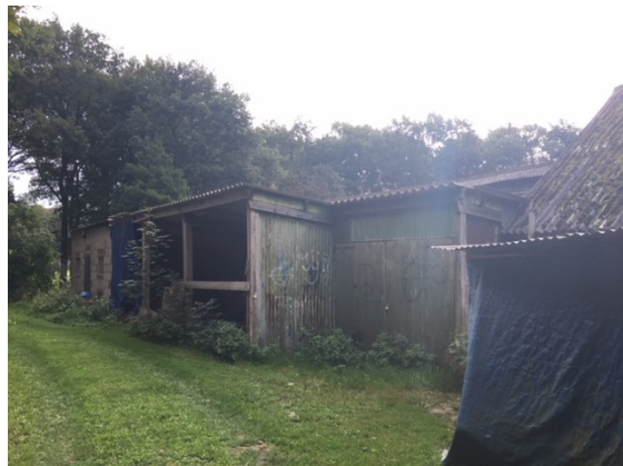
Afb. 3.4. Opstallen aan noordzijde schuurwoning
