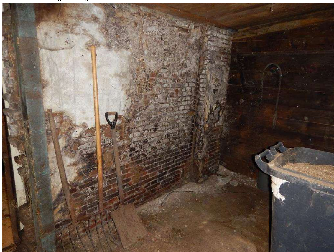
10 Muur in de stalzijde ook deels voorzien van pleisterwerk.
