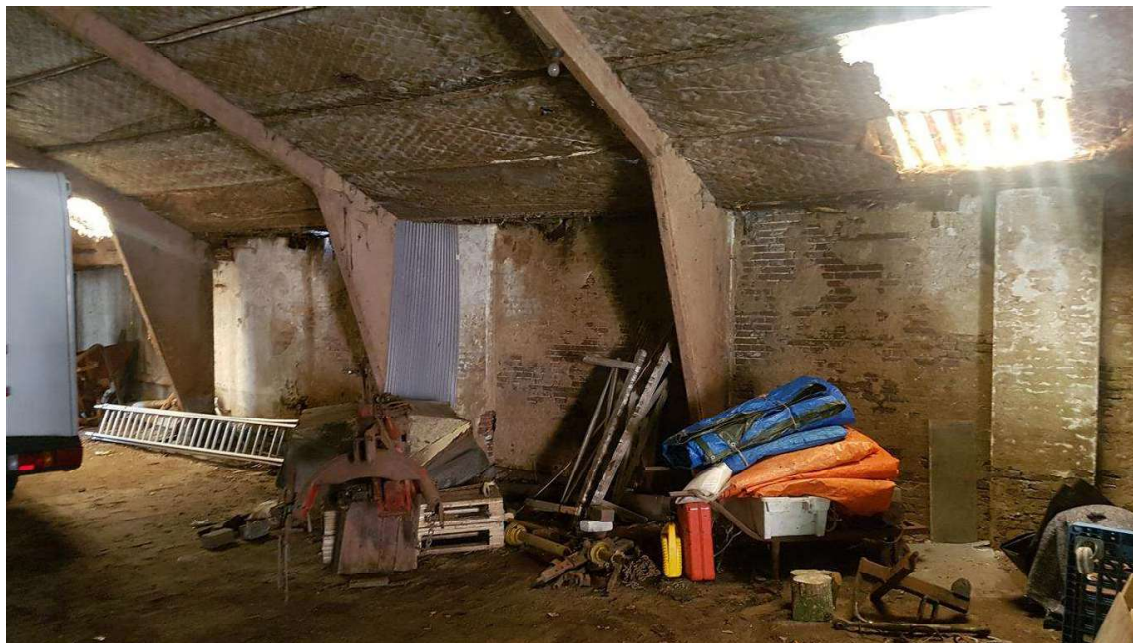
01 Gevel gezien in de stal met in het tuinmuurmetselwerk lisenen/steunberen.
