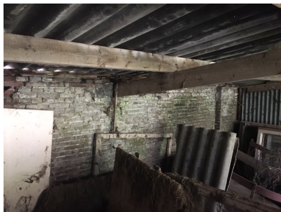
Afb. 3.8. Binnenzijde opstal zuidzijde
