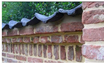
Rollaag en afdekking met oud-Hollandse pannen.
