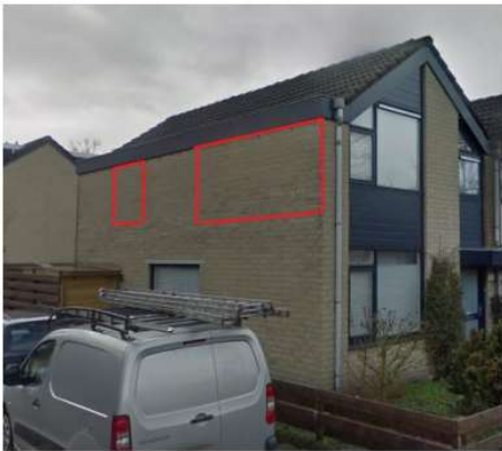
Figuur 5: Geschikte ruimte voor plaatsen inbouwkasten (voorbeeld voor kopgevels woningencomplex OHCL-9002).
