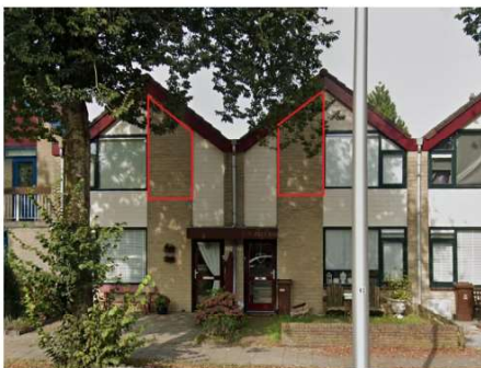
Figuur 8: Geschikte ruimte voor plaatsen inbouwkasten (voorbeeld voor voorzijdes woningencomplex OHCL-9002).
