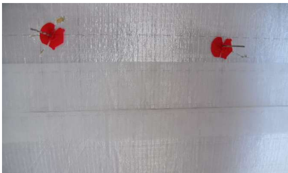
Figuur 1: Gripgaas GG2 aangebracht op de isolatielaag.
