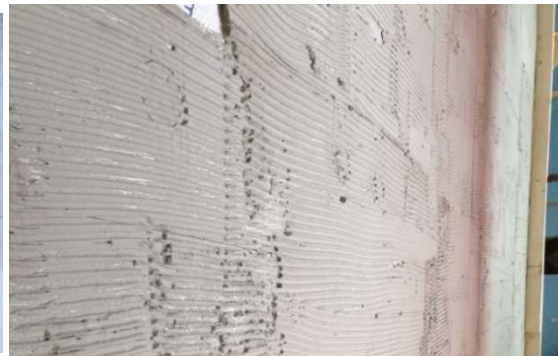
Figuur 1: Cementlaagje aangebracht met een lijmkam op de isolatielaag.
