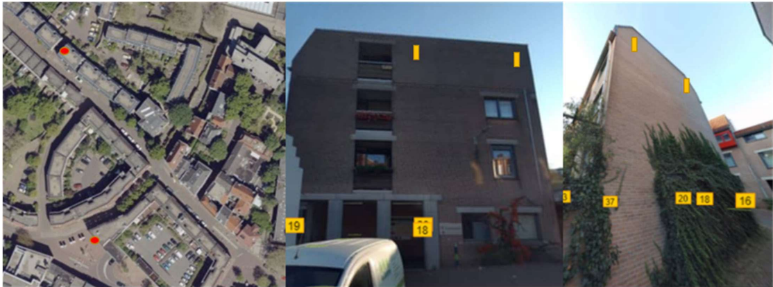
Figuur 2: Locaties tijdelijke vleermuisvoorzieningen (Muchterstraat 23 t/m 27, Snijderstraat 4 t/m 48 te Nijmegen). Links: ligging locaties (rode stippen) op kaart. Midden: locaties van vleermuis-voorzieningen (gele rechthoeken) op gevel Snijderstraat. Rechts: locaties van vleermuisvoorzieningen (gele rechthoeken) op gevel Muchterstraat. Afbeelding afkomstig uit: Overmeire 2022.
