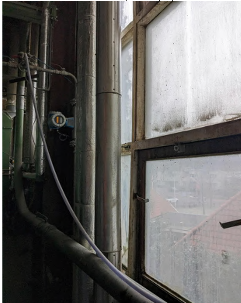
5. Ramen in fabriekswand ABZ (binnenzijde)
