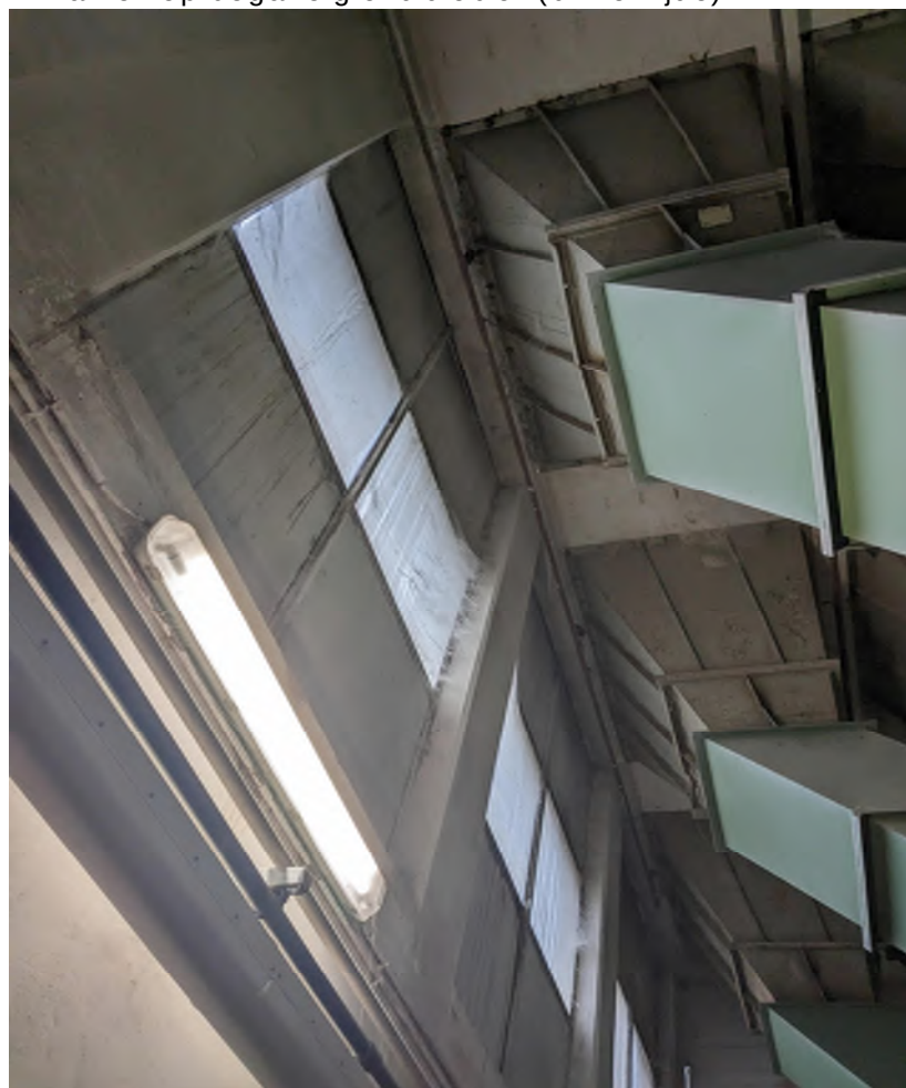
4. Ramen op begane grond siloblok (binnenzijde)
