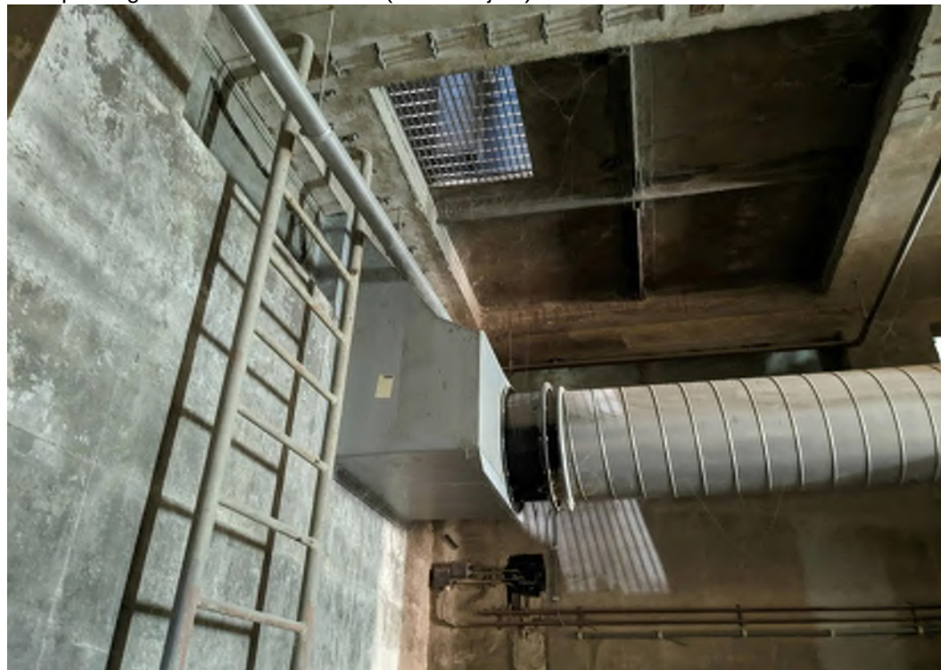
3. Opening in fabriekswand ABZ (binnenzijde)
