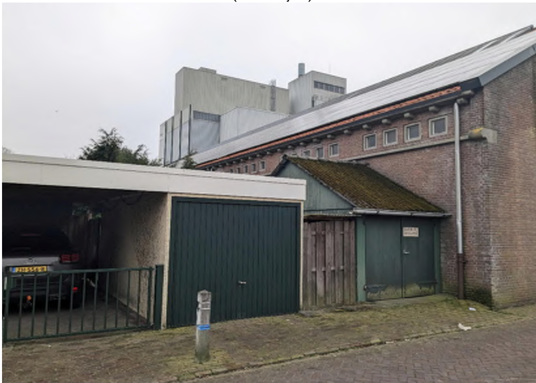
7. Ramen in wand kunstmestloods (buitenzijde)
