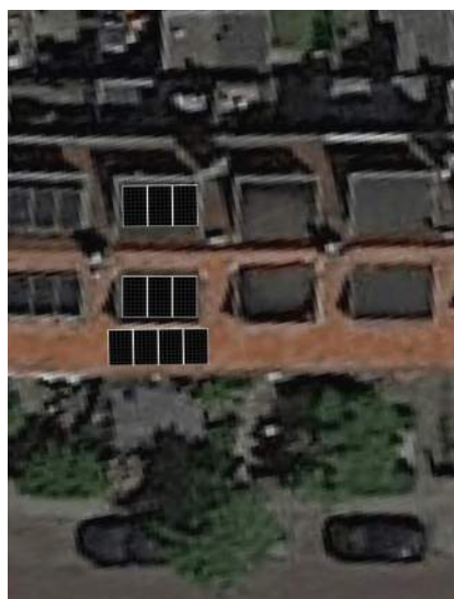
Impressie panelen op dak Stieltjesstraat 22, 2313SK Leiden
