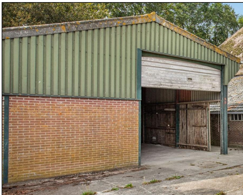
Afbeelding: de foto toont de constructie/staat van het te slopen bijgebouw.
