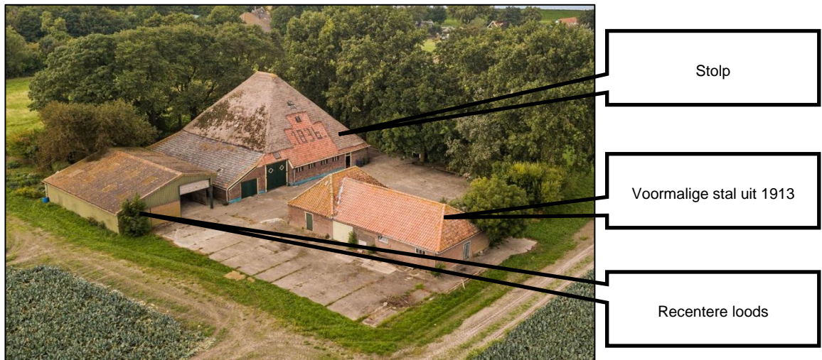
Afbeelding: weergegeven is het plangebied. Zichtbaar is de stolp op de noordwesthoek van het perceel. Ten oosten daarvan staat de voormalige stal uit 1913. Ten zuiden van de stolp is de recentere loods zichtbaar. De overige delen van het erf zijn verhard.
