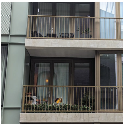
inpendige balkons als uitsparingen in de gevel
