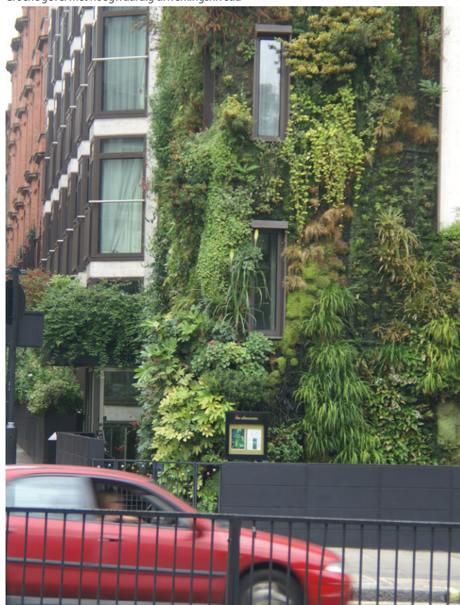
Groene gevel met hoogwaardig afwerkingsniveau
