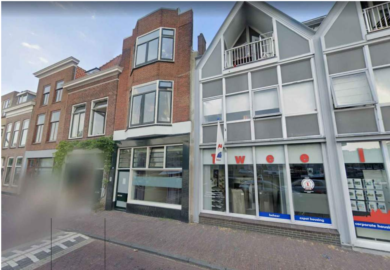
voorgevel gezien vanaf de Oude Herengracht
