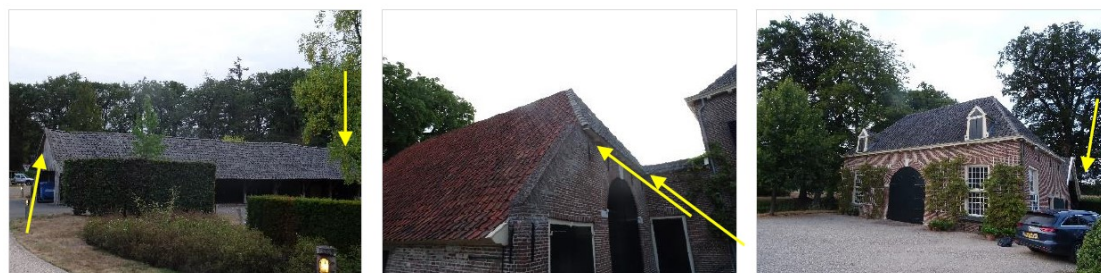
Figuur 5. Overzicht van de invliegopeningen voor de gerealiseerde voorzieningen voor gewone grootoorvleermuis zoals weergegeven in figuur 3 en 4. Open kapschuur (links); bijgebouw met meerdere invliegopeningen onder de dakpannen (midden); bijgebouw achter koetshuis met ruimte achter betimmering en poort (rechts).
