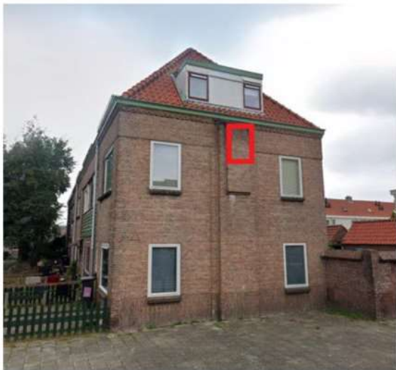
Figuur 1: Een van de pendanten op de kopgevel van de woningen met de voorgenomen locatie voor de inbouwkast.
