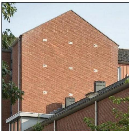
Afb 19 + 20: Gierzwaluwkasten ingemetseld (worden ook gebruikt door Huismussen)
