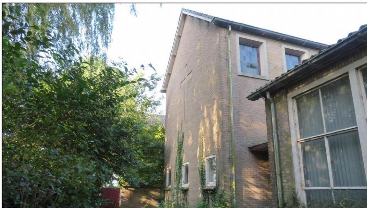
Afb 6: Overzichtsfoto. Boven enkele kozijnen omkaderd met een betonnen element
