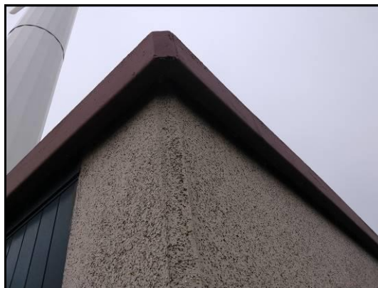
Afbeelding 5: Ruimte achter overhangende dakrand
