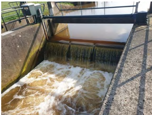
Figuur 56 Stuw Bakkebrug (overlaatconstructie)
