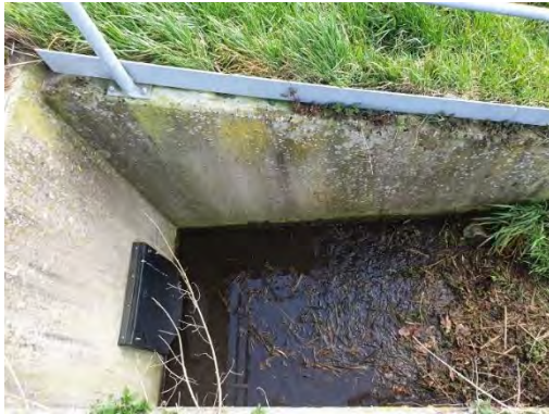
Figuur 54 Sluiskens (uitlaatsconstructie)
