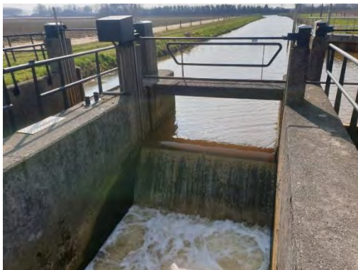
Figuur 68 Stuw Wernhout (overlaatconstructie)
