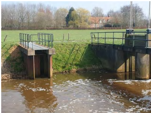
Figuur 58 Stuw Bakkebrug (vispassage)
