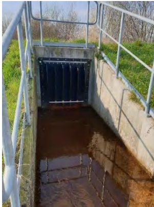
Figuur 48 Boontuinen (uitlaatconstructie)
