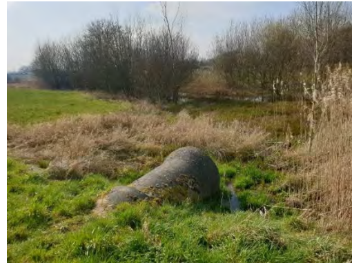
Figuur 49 Boontuinen (uitlaatconstructie buitenbocht)
