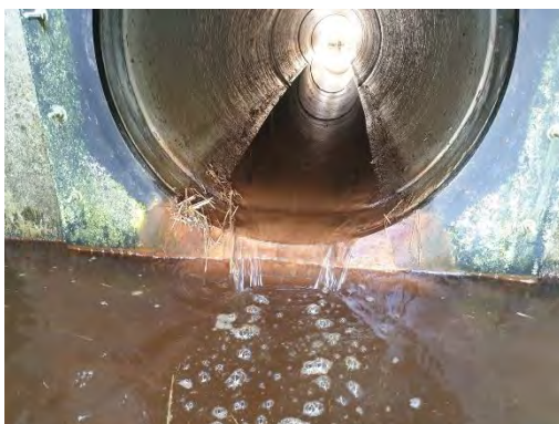
Figuur 80 Uitlaatconstructie waterberging Mortelbeek
