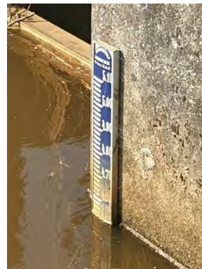
Figuur 57 Stuw Bakkebrug (peil +4.50)
