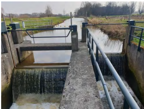
Figuur 72 Stuw Wielhoef (overlaatconstructie)
