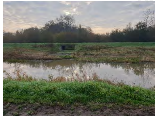
Figuur 77 Inlaatconstructie Mortelbeek (afbeelding vanaf overkant oever)
