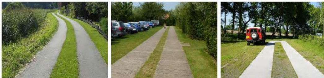
Figuur 7-20 Referentiebeelden karrespoor met betonen rijlopers
