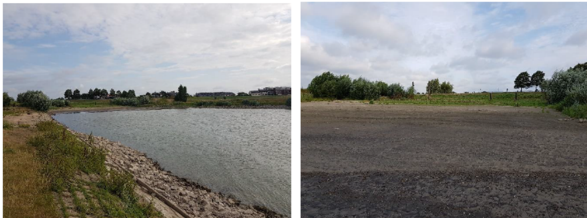
Figuur 2-5 Havenkom met zichtbare hoogtesprongen en aanlanding
