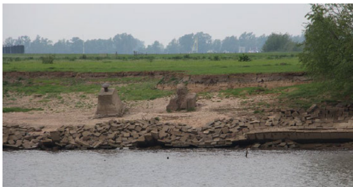
Figuur 3-1 Impressie verzakte verdediging westelijke oever veerhaven
