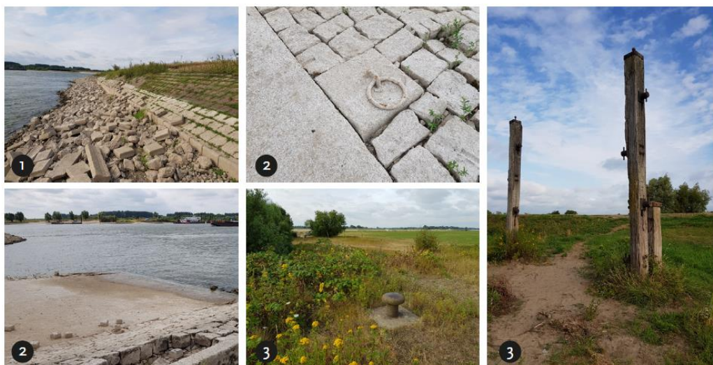
Figuur 5-9 Kenmerkende elementen van de veerhaven ([1] overbescherming, [2] veerstoeep, [3] aanlegvoorzieningen bolder en meerpalen)
