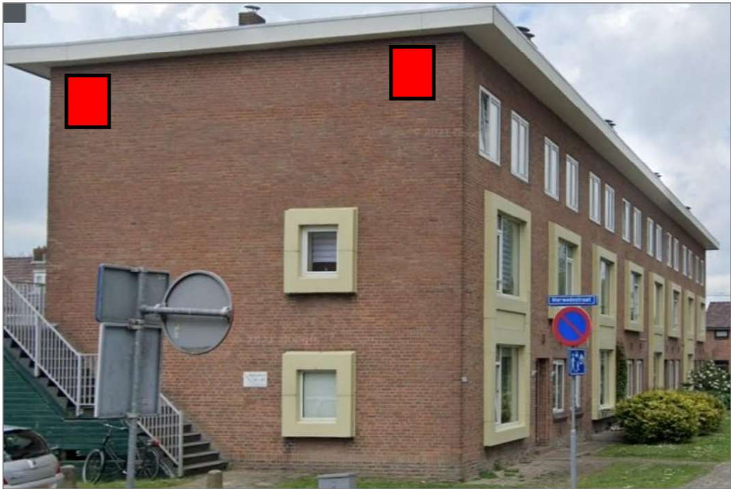
Afbeelding 2.4 | Locatie van 2 permanente vleermuiskasten (rood) aan kopse gevel Wierselaan 67-89 (zuidkant).
