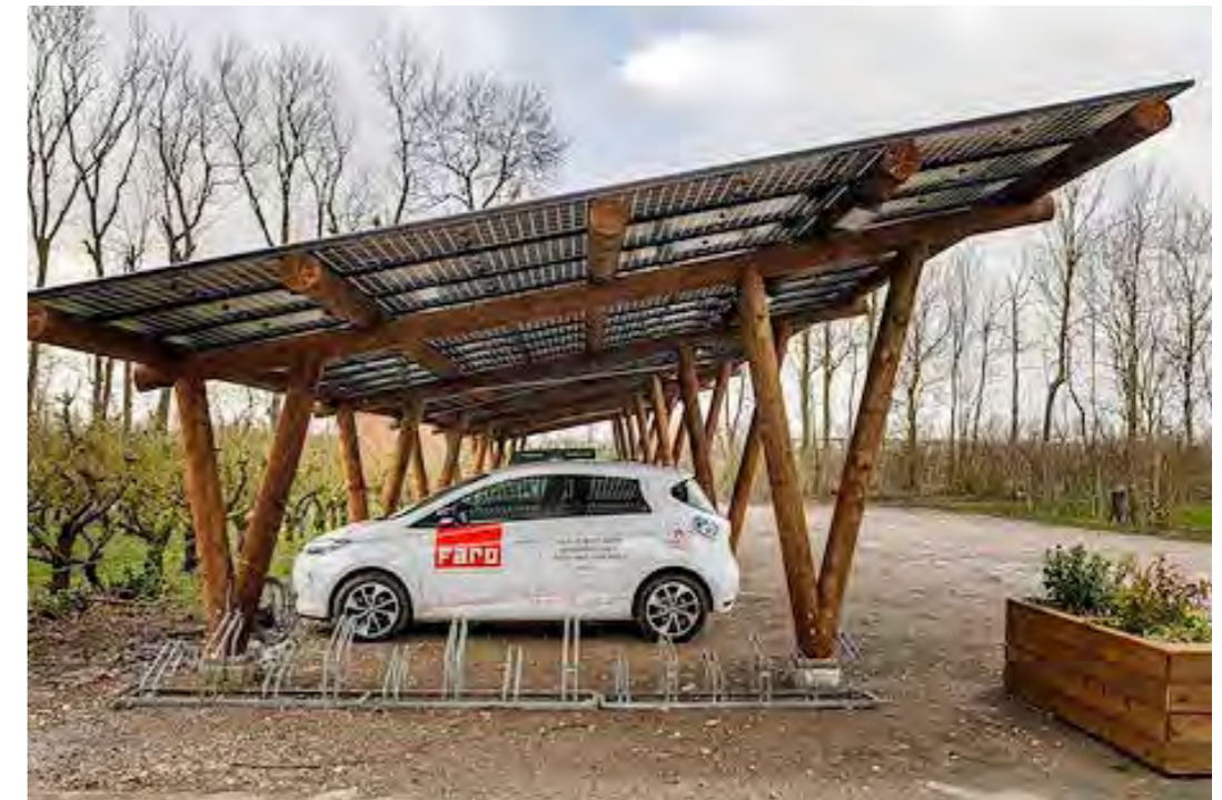
Referentie halfverhard parkeren zonnecarport Lisserbroek, FARO architecten
