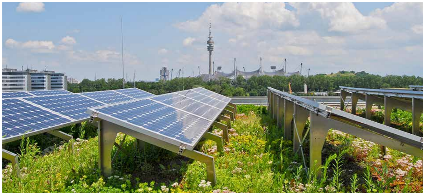
Referentie sedumdak met zonnepanelen www.greenpro-online.be
