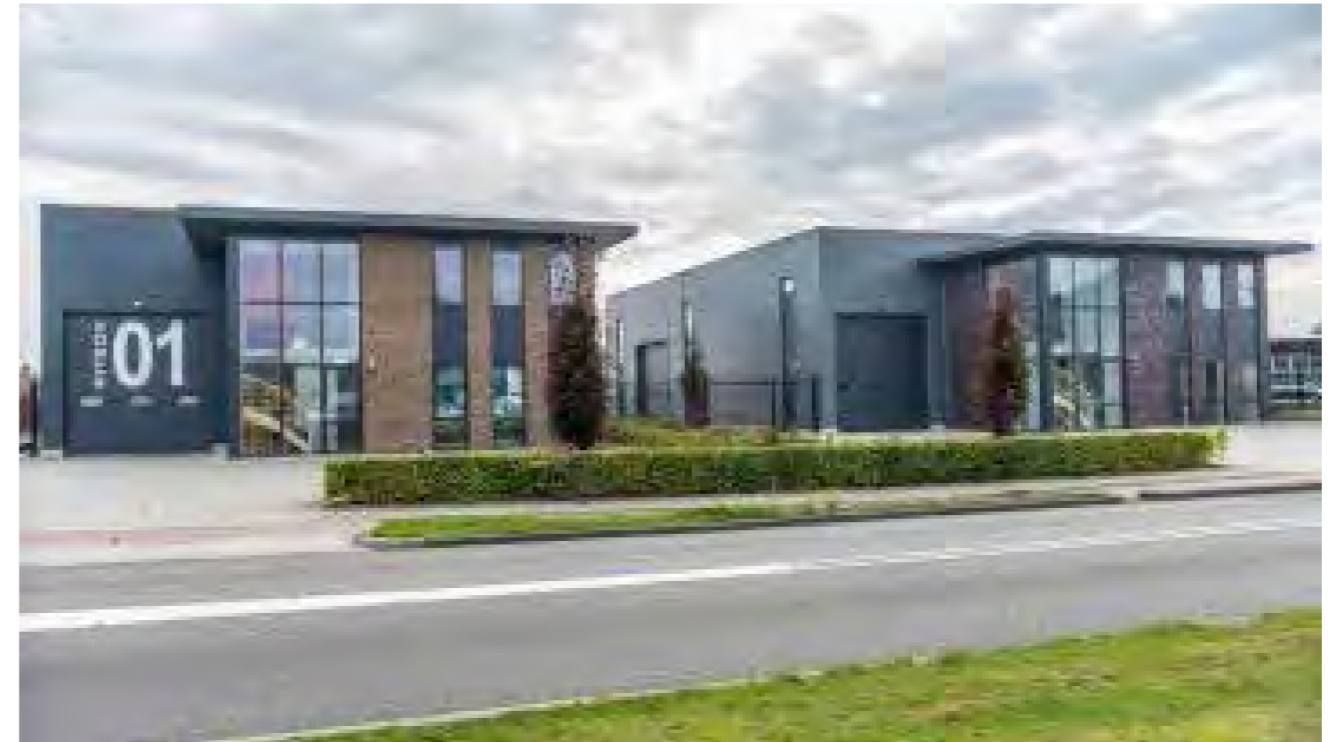
Twee architectonisch vormgegeven bedrijfspanden met kantoorruimte, Hoogeveen. - www.abbouw.nl
