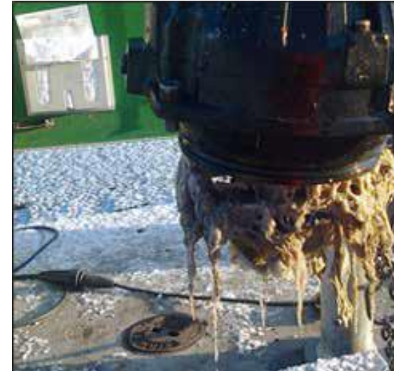
Afbeelding 3-6. Verstopping van een pomp door doekjes
