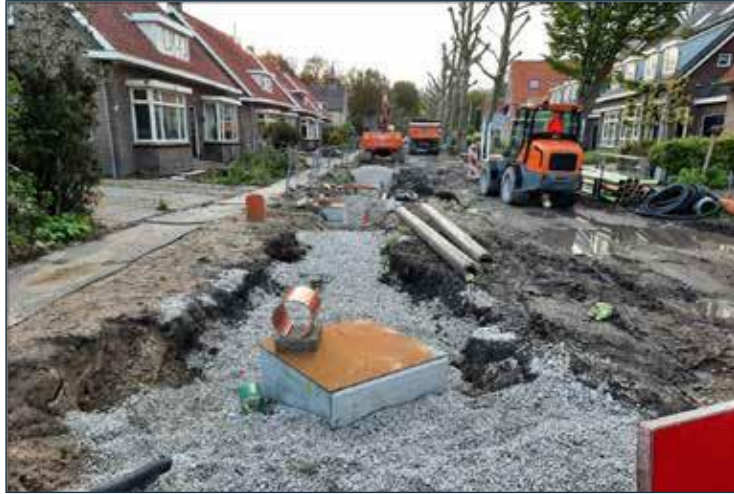
Afbeelding 4-2. Vervanging van het riool
