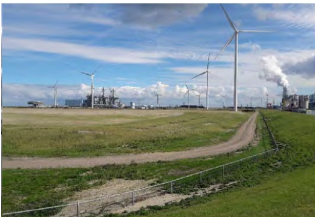
Terrein waar de staalfabriek gebouwd wordt, gezien vanaf de huidige dijk.
